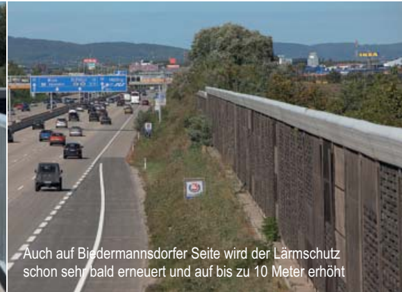
Kurz vor Fertigstellung der sanierten Brücke über die A2 (Verbindung Biedermansdorf – Wiener Neudorf). Deutlich zu erkennen: der erheblich verbreiterte Gehsteig
