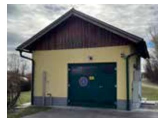
HAW Pumpwerk Spitzweise
